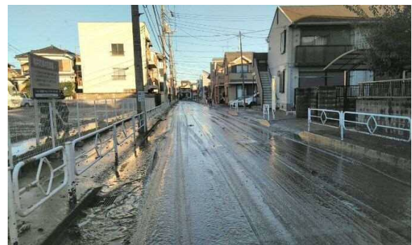
猪駒通りに堆積した泥土の状況
