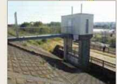
猪方排水樋管
