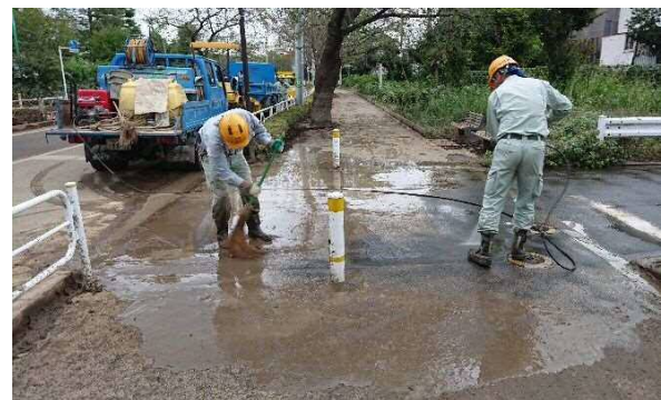
歩道の高圧洗浄作業を行う狛江市建設業協会
