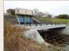
六郷排水樋管
