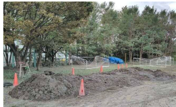
西和泉グラウンドに集積された泥土の一部
